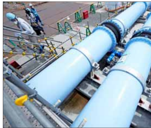
El agua contaminada es tratada con el sistema ALPS, capaz de retirar por completo 62 tipos de materiales radiactivos, a excepción del tritio y del carbono-14.
